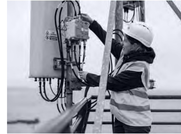
Instalação de equipamentos
