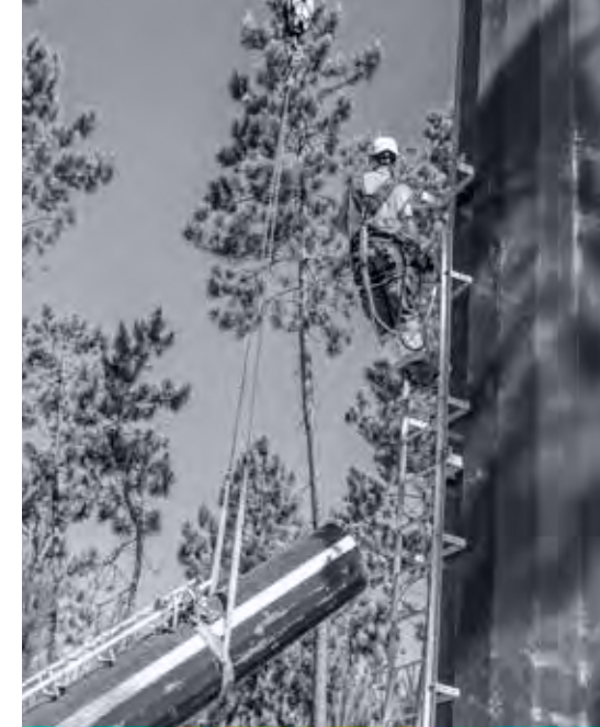
Construção de infraestruturas
